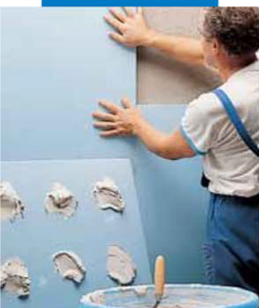
Монтаж полистироловых плит с помощью белого клея Keraflex
