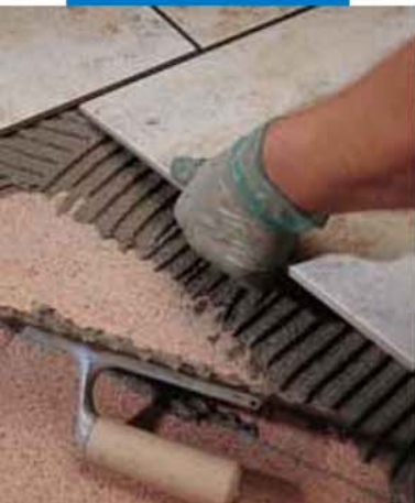
Укладка плитки одинарного обжига на стену снаружи помещения, облицованную террасой
