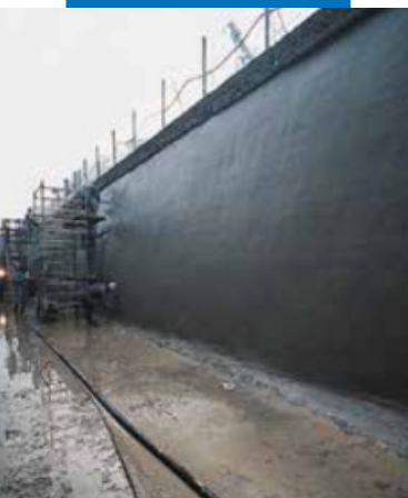
Канал гидроэлектростанции в г. Бертини-Роббьяте (Область Комо): общий вид
