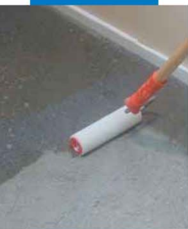
Нанесение Primer G валиком
