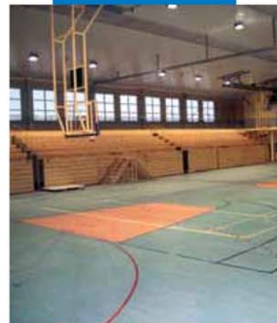
Пример использования Primer G перед укладкой ПВХ и линолеума в спортивном зале - Спортивный зал Гданск Оруна - Польша
