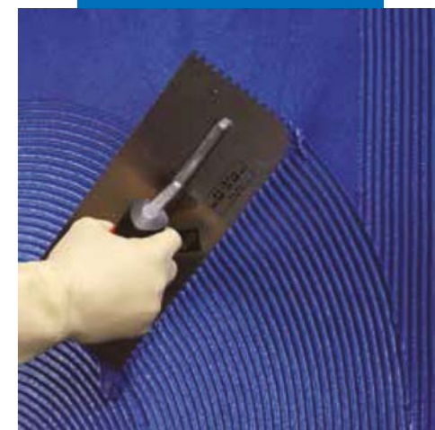
Нанесение Kerapoxy Design синего цвета в качестве клея при помощи зубчатого шпателя
