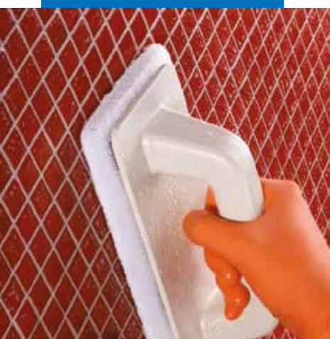
Очистка стеклянной мозаики влажной абразивной губкой Scotch Brite®
