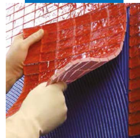
Укладка стеклянной мозаики с помощью Kerapoxy Design на стены
