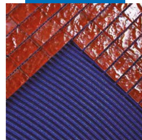
На следующий день, заполнение швов Kerapoxy Design того же цвета, с соблюдением выше указанной процедуры заполнения швов
