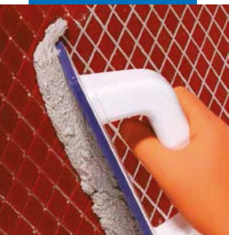
Нанесение Kerapoxy Design плоским резиновым шпателем
