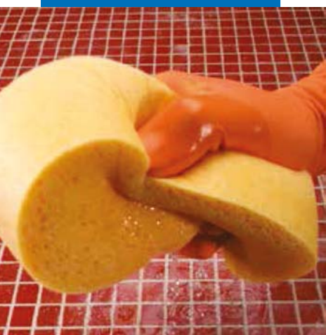
Смачивание поверхности перед очисткой
